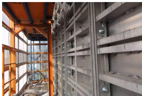
图 3.4-2 爬模模板及架体
