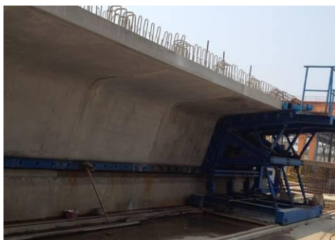
图 3.8-1 长线预制节段箱梁模板
