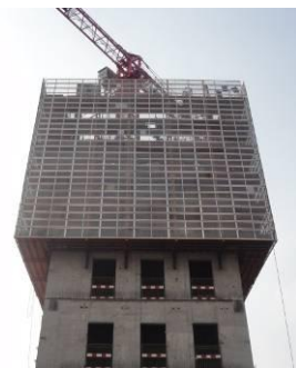
图 3.4-1 液压爬升模板外立面
