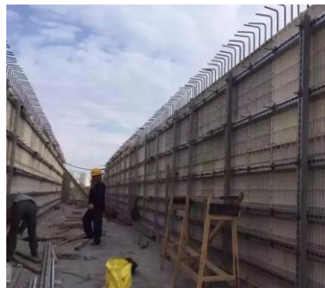
2 混凝土分三次浇筑的模板
