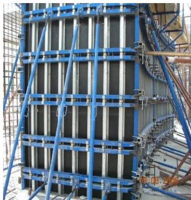
图 3.7-2 清水混凝土模板实例
