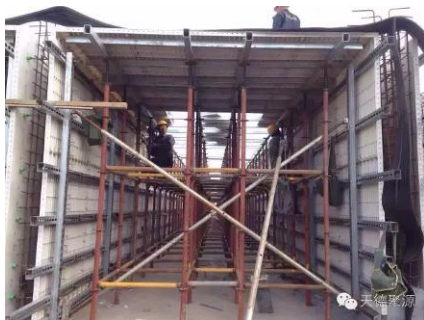
1 混凝土分两次浇筑的模板
