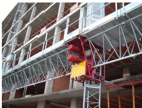
图 3.3 电动桥式脚手架
