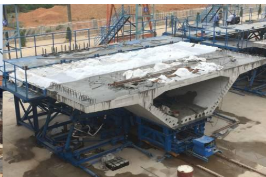
图 3.8-2 短线预制节段箱梁模板
